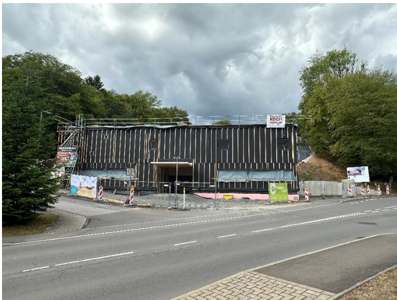
Foto: © S. Fielstette, Stadt Overath. Beim Richtfest wurde der aktuelle Baufortschritt der neuen Einfeld-Sporthalle sichtbar. Der nachhaltige Holzbau soll im zweiten Quartal 2027 fertiggestellt werden und künftig der Gemeinschaftsgrundschule sowie örtlichen Sportgruppen zur Verfügung stehen.
