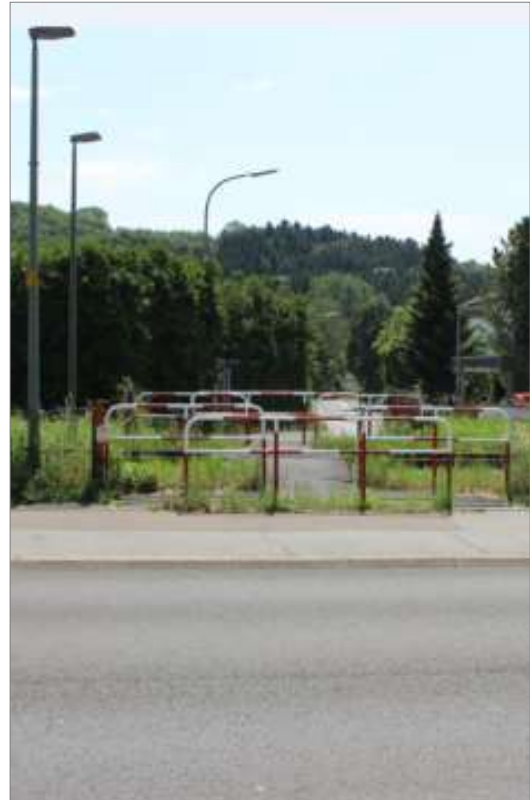
Abb. 38: Bahnübergang Siegburger Str. Quelle: eigene Bilder
